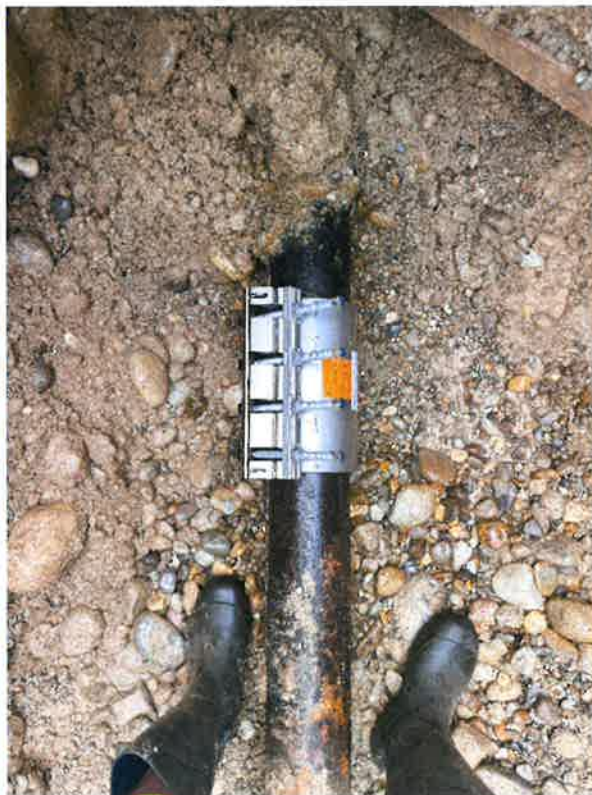
Réparation de fuite – Avenue Général-Guisan – Rolle – sept. 2025
