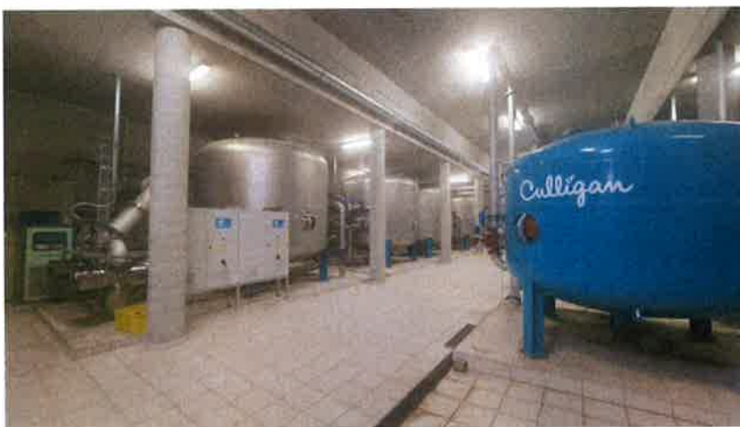
Intérieur de la station. Source : SIDERE
