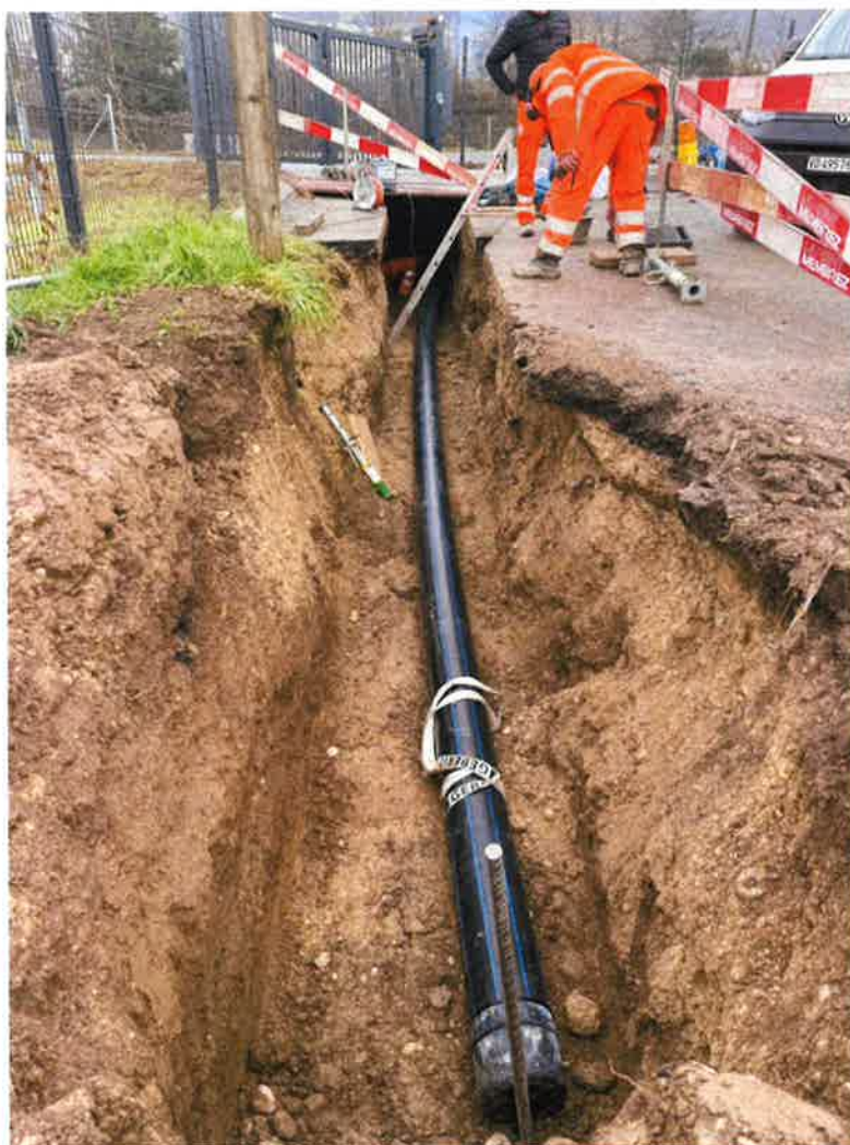
Chemin de Jolimont 'Nord' à Rolle - sous accès Schenk
