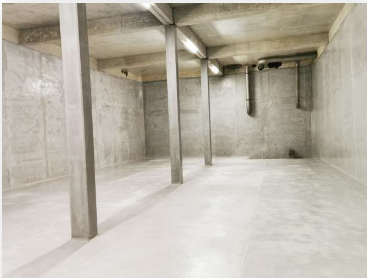
Ancienne cuve rénovée de Champ-Jaillet
