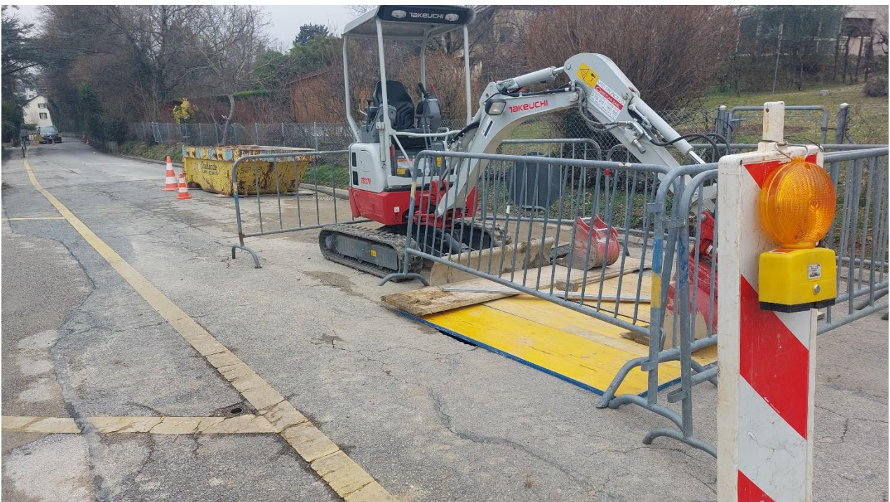
Réparation en cours
