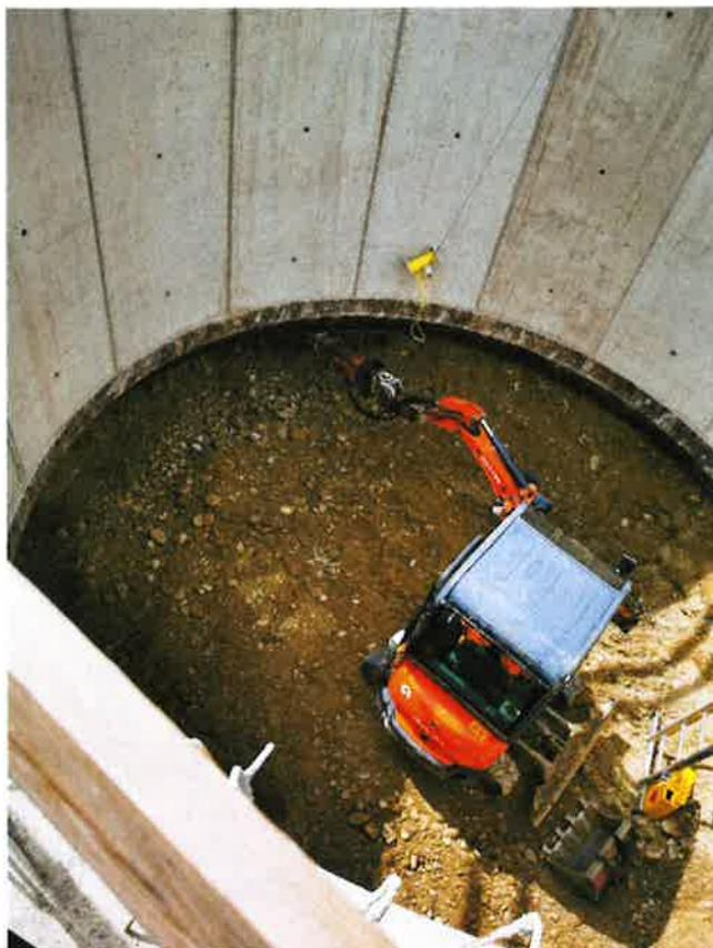
Photo n°9 : Piquage au marteau de la roche dure
