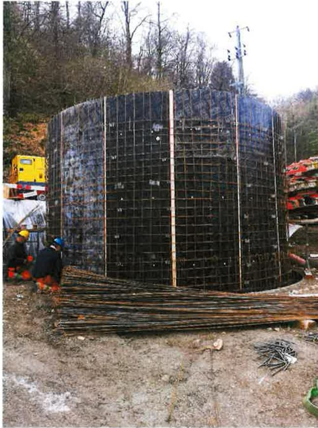
Photo n°3 : Suite du coffrage et préparation de l'armature
