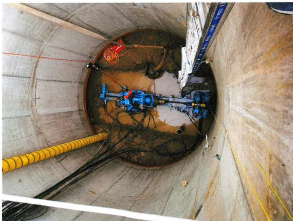
Photo n°10 : Forage d'un drain
