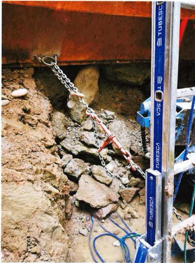
Photo n°11 : Effondrement du terrain sous le coffrage
