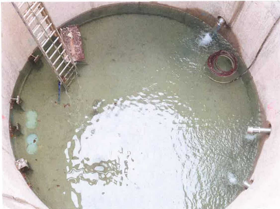
Photo n°14 : Fond du puits avec les 3 drains de captage en service
