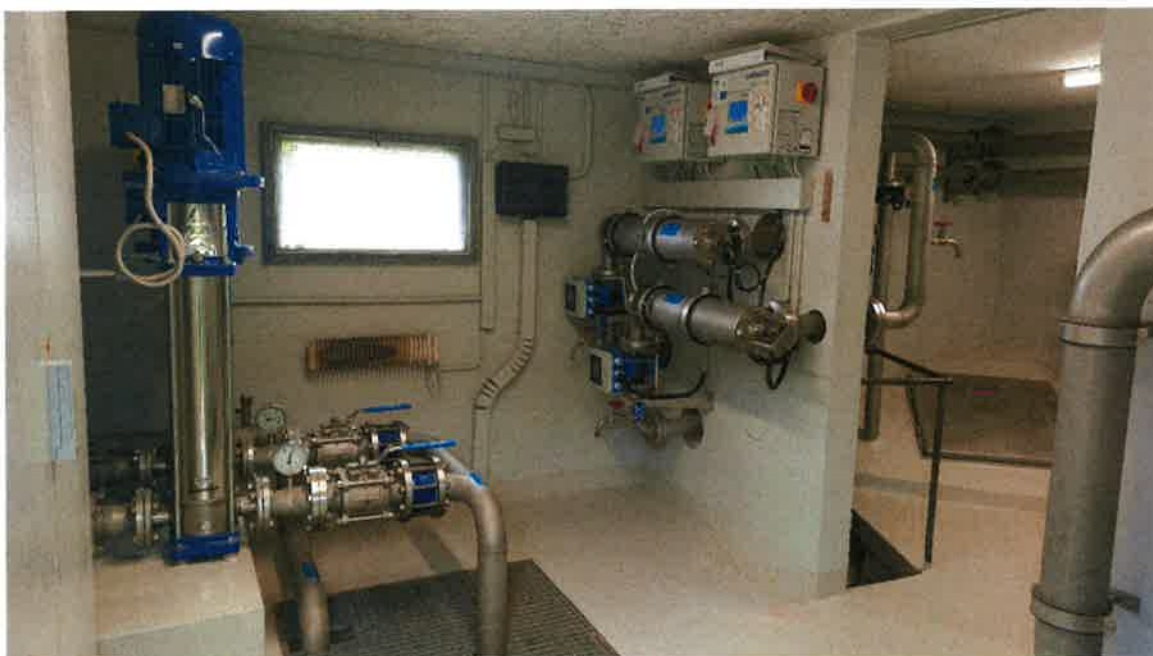
Rénovation du Réservoir du Château
