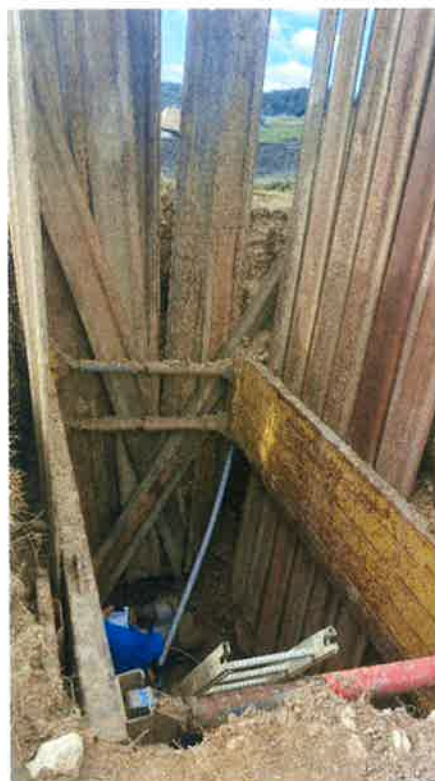
Sondage pour la recherche du câble de télécommande qui a été déconnecté du réservoir de Montbenay
