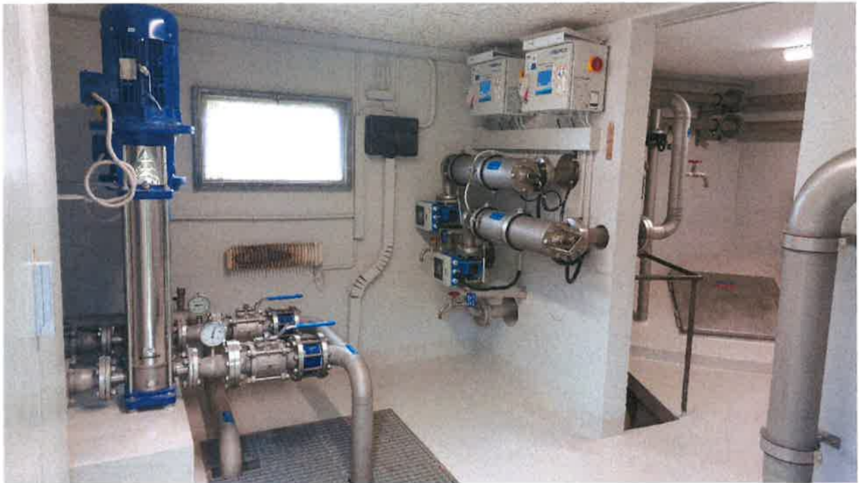
Rénovation du réservoir du Château à Mont-sur-Rolle
