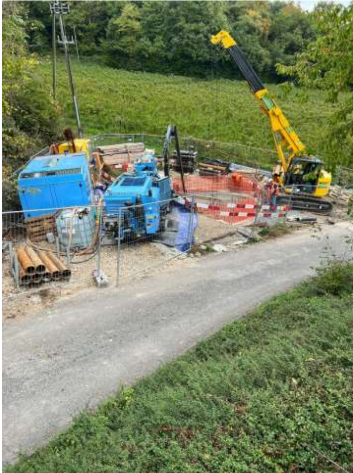
Réfection du captage de la source du Rosey à Bursins
